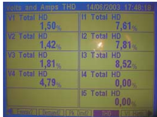
FIGURA 6. Medição de taxas de distorção harmônica de tensão
