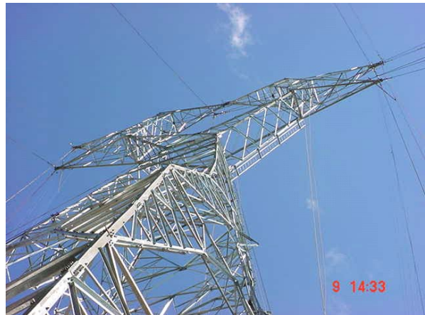
FIGURA 6 – FALHA DA ESTRUTURA B55.
