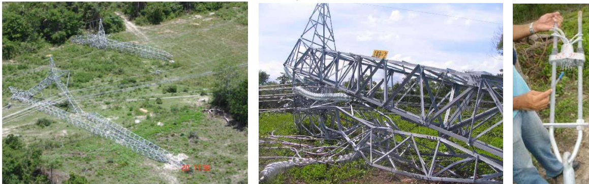
Figura 2 – Detalhe das torres derrubadas e do vandalismo nos pré-formados dos estais.
