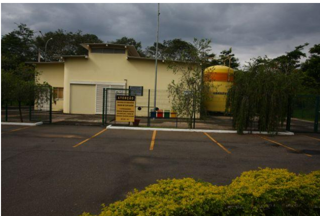
Figura 1. Laboratório Experimental de Hidrogênio - Cemig – Juatuba/MG.
