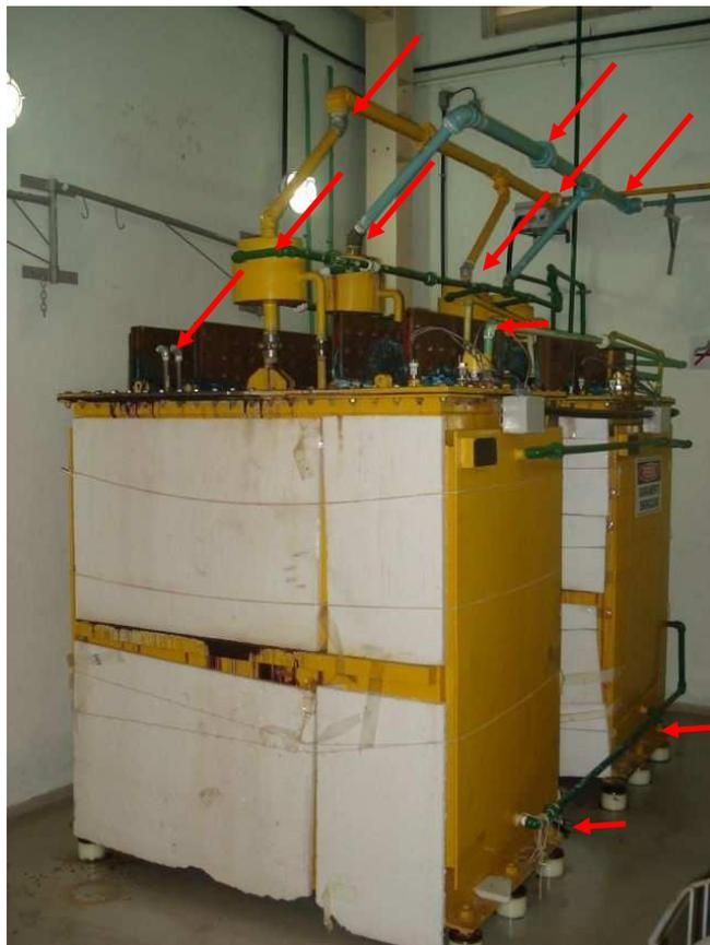
Figura 6. Problemas nos eletrolisadores: vazamentos de solução e de gás.
