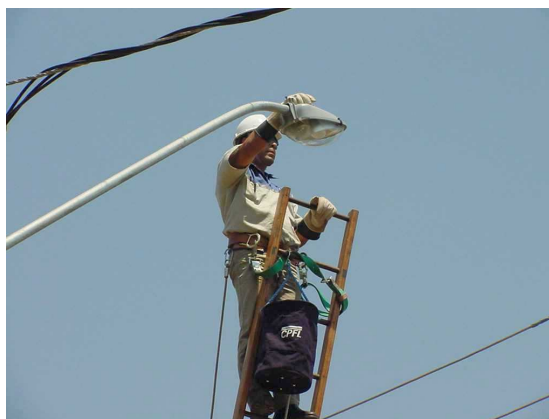
figura 4 – Manutenção da Iluminação Pública com luminária integrada
