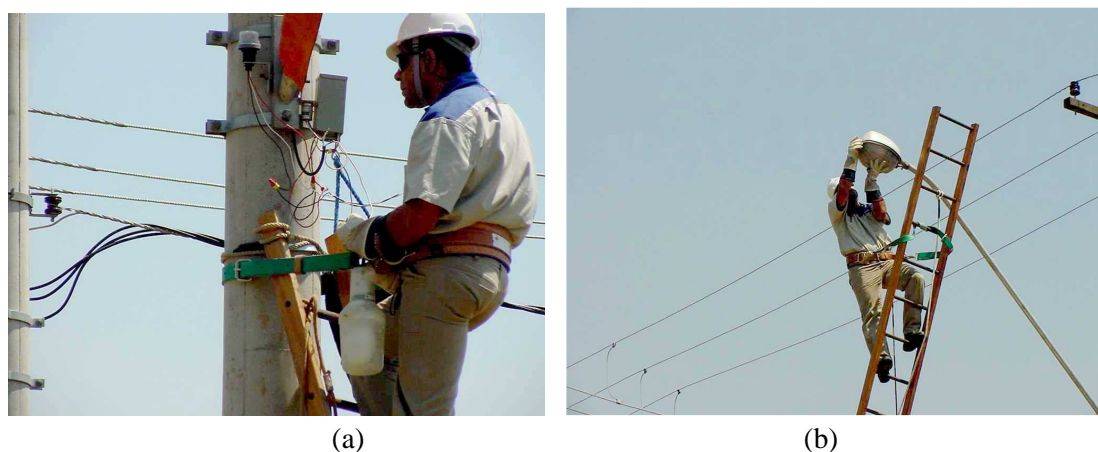
figura 5 – Manutenção da Iluminação com luminária convencional (a) no poste (b) na luminária
