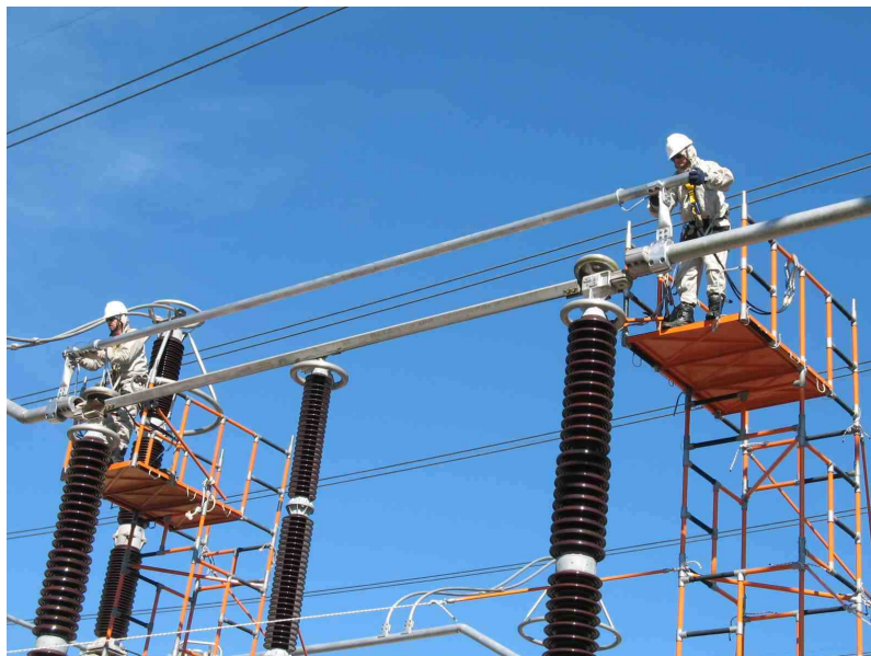
FIGURA 1 – Instalação do jampe tubular no seccionador.
