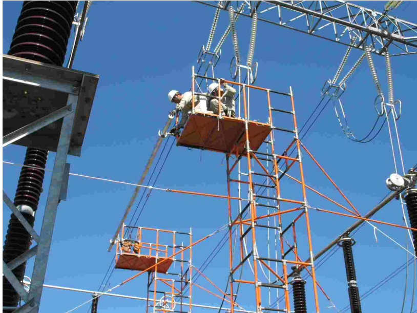
FIGURA 4 – Instalação do jampe com andaimes isolantes.
