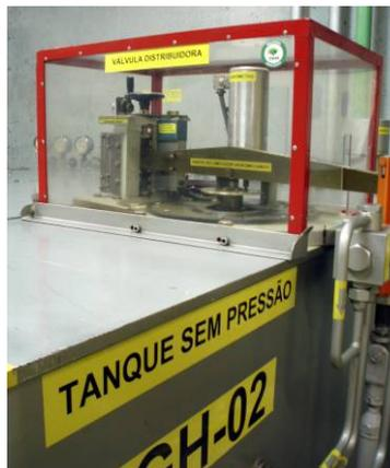
Figura 4 - Válvula distribuidora e variômetro de medição de posição (Eletronorte – UHE de Tucuruí).
