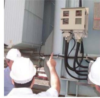
Figura 1 – IEDs no corpo do transformador Asea
