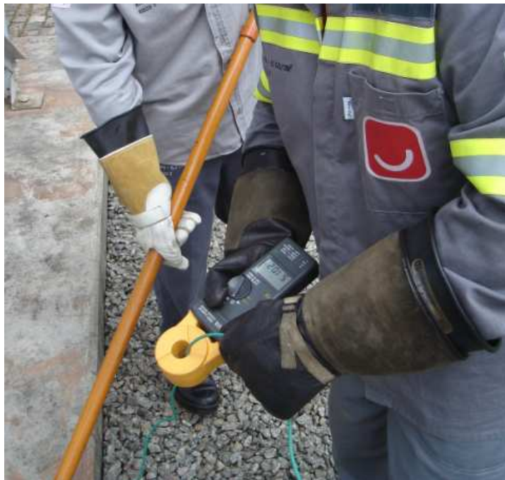
Imagem 7 – Medição da resistência com o alicate terrômetro
