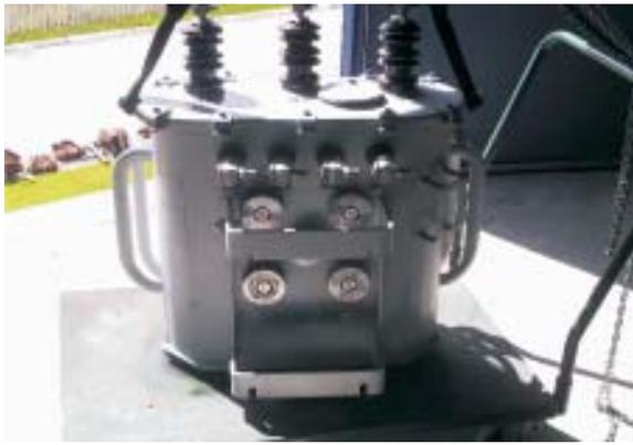
FIGURA 15: Transformador com neutralizadores instalados – parte traseira.
