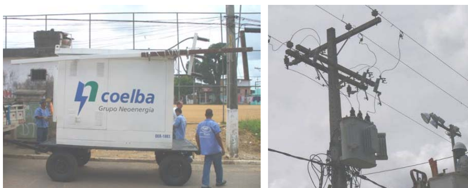
FIGURA 1 – UNIDADE MÓVEL E TRANSFORMADOR EM SUBSTITUIÇÃO
