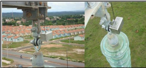
Figura 5 - Detalhe da instalação do sensor de corrente de fuga
