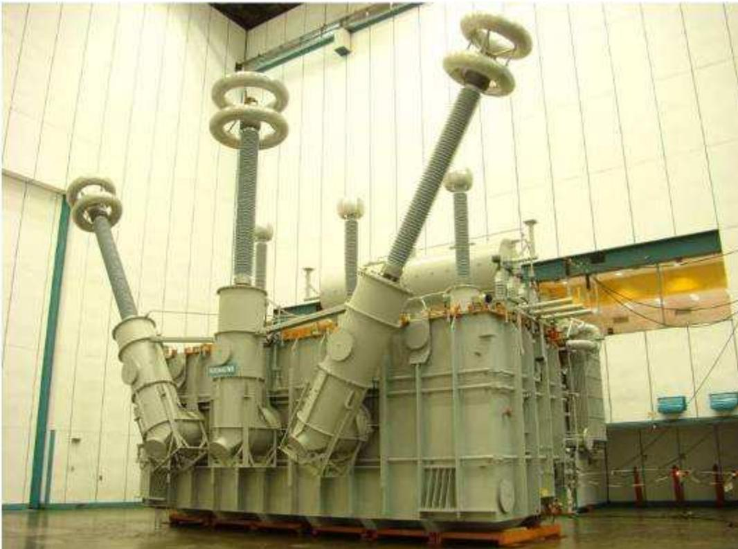
FIGURA 1 – Exemplo de transformador a óleo de grande potência e elevada tensão
