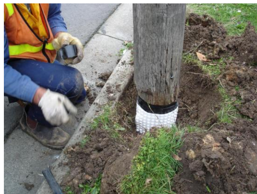
Fotos 5 e 6 – Área urbana de Melbourne, na Austrália, com postes de madeira na área urbana e realização de manutenção em parte da região engastada.
