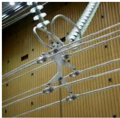
FIGURA 6 – Detalhe da ferragem da fase central
