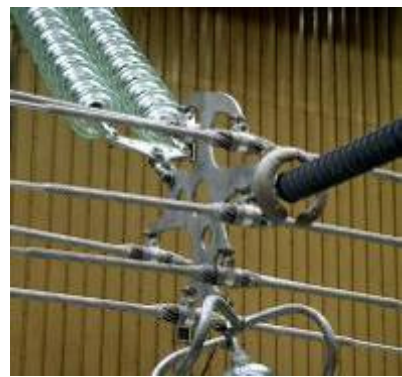
FIGURA 7 – Detalhe da ferragem da fase lateral
