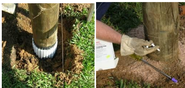
Figura 3 – Aplicação dos preservativos: (a) externo na forma de bandagem Bioguard e (b) interno na forma de bastonetes Polesaver (Preschem, Austrália).
