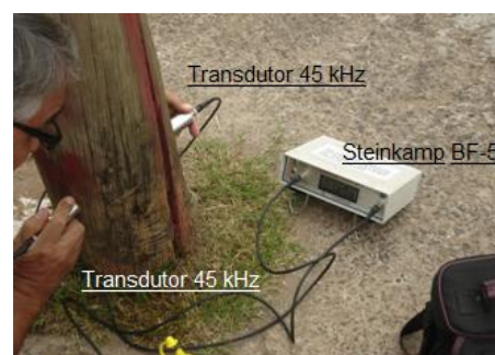
Figura 2. Medição com ultrassom em poste de madeira em serviço.
