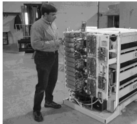
Fig. 2 – 313 kVA/250 kW Power Conversion Module
