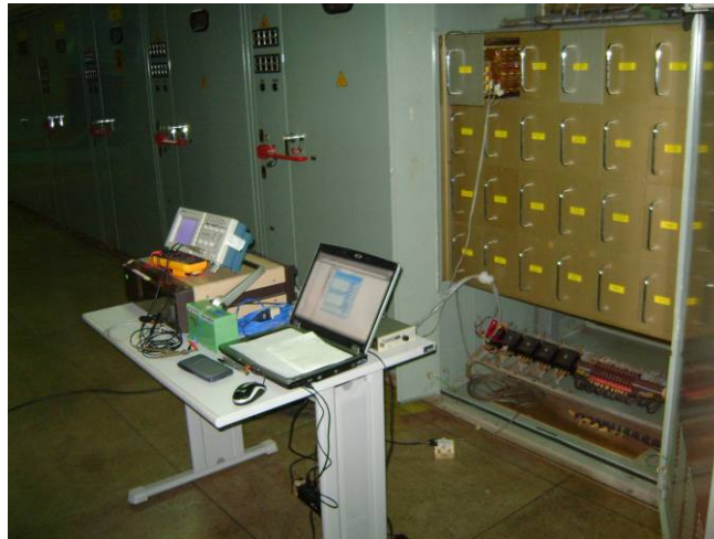
Figura 2 – Instrumentos instalados ao lado do armário do RAT durante os testes em campo na UHE de Tucuruí.
