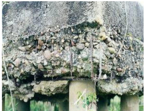
Figura 15 – Fundação em banhado adensado.
