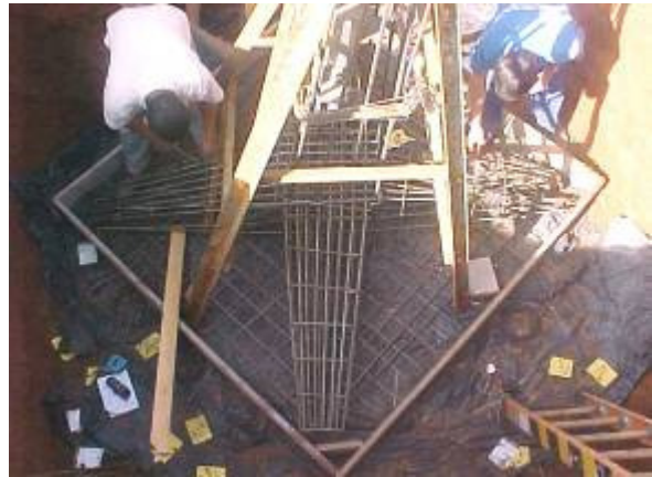
Figura 10 – Fundação reforço em sapata.
