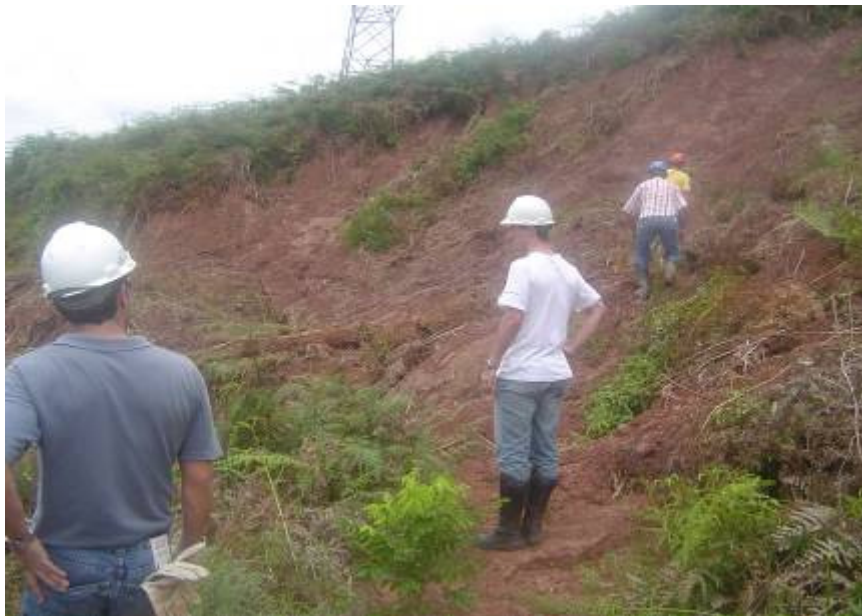
Figura 11 – Deslizamento em encosta instável.
