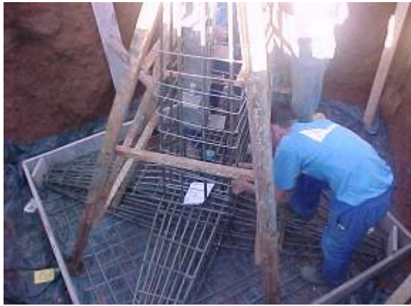
Figura 9 – Fundação reforço em sapata.
