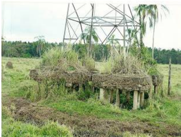
Figura 14 – Fundação em estacas em banhado adensado.
