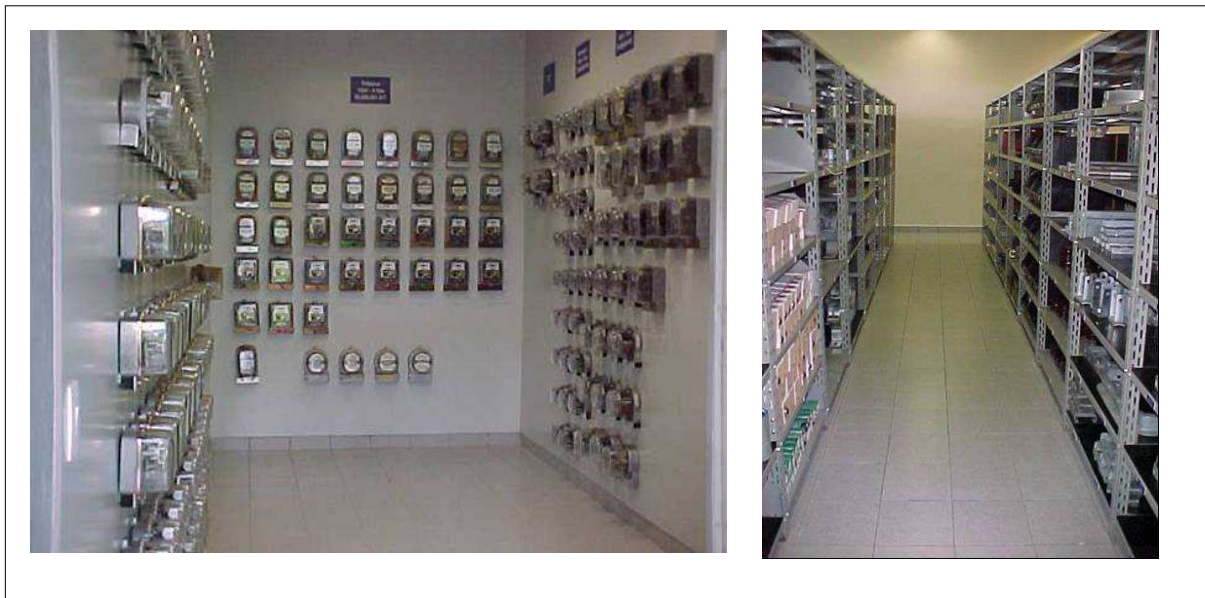
Figura 6 – Almoxarifado da CPFL – Sede Regional de Bauru
