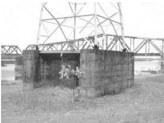
Figura 3. Detalhe da fundação das torres da travessia.
