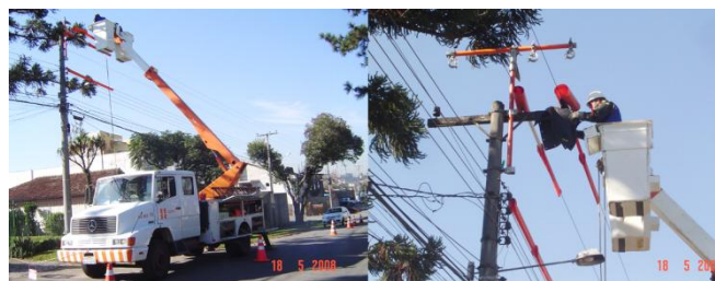
Figura 2. Atividade de manutenção em linha viva.
