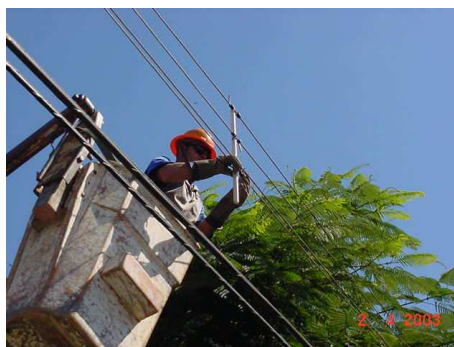
Figura 15 – Instalação de espaçadores
