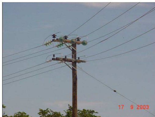
Figura 16 – Circuitos 34,5 e 11,95 kV
