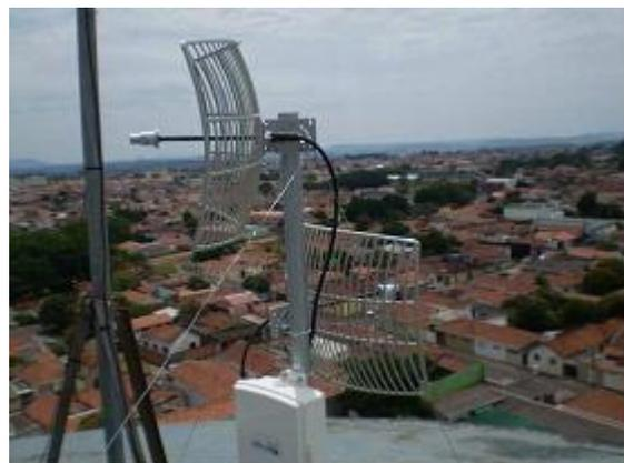
Figura 3 – Antena e caixa hermética com rádio.
