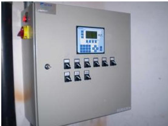
Figura 2 – Um dos painéis com CLP.
