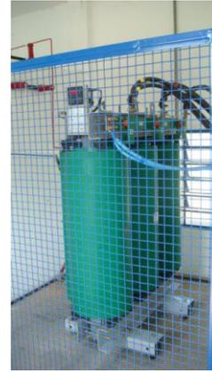
Figura 2 – Novo transformador 500 kVA.
