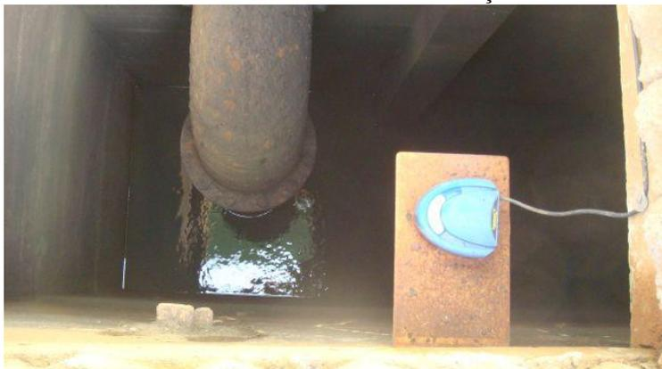
Figura 5 – Sensor de nível de água tratada.
