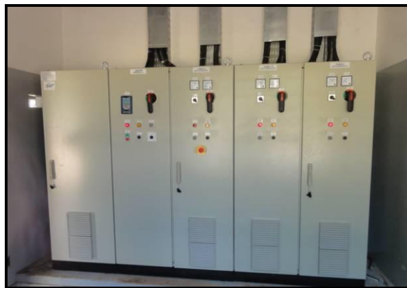
Figura 4. Painel com inversor e Soft-Starters da Captação Hemínio Ometto
