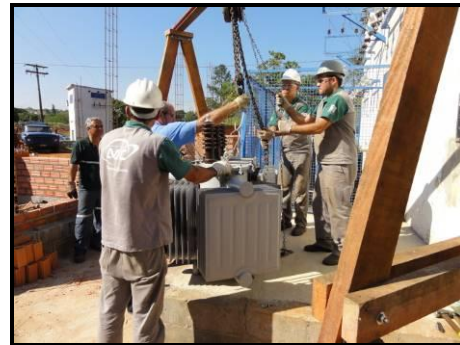
Figura 3. Transformador de 300 kVA
