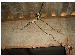
**Imagem 01-** Situação em que a isolamento é feita com sacola plástica, colocando a moradia em risco de incêndio devido material ser inflamável.
