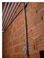
**Imagem 02 -** Instalações reformadas utilizando condutes
