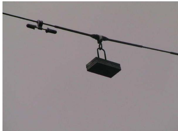
Figura 3 - Pesos adicionais e amortecedor
