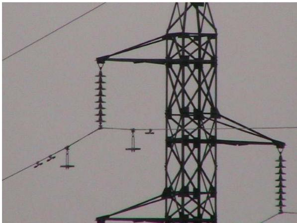
Figura 2 – Torre com amortecedores e pesos adicionais
