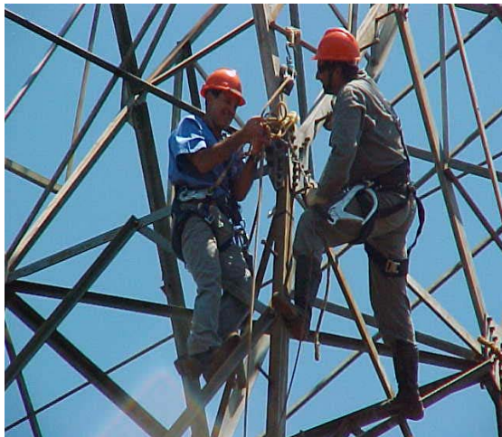
FIGURA 1 - Colocação de Estais.
