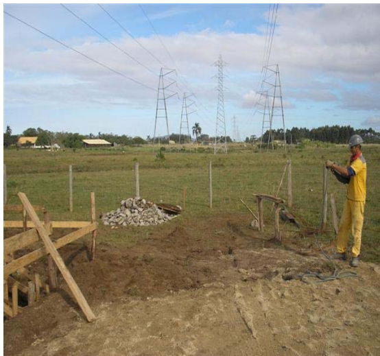
FIGURA 3 - Reforço com LT energizada.
