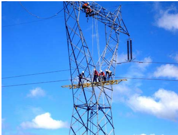
FIGURA 5 – Execução de ancoragem móvel no alto.
