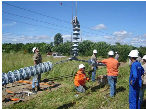
FIGURA 6 – Execução da ancoragem móvel no solo.
