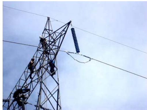
FIGURA 4 – Ancoragem móvel sem as pencas de ancoragem.
