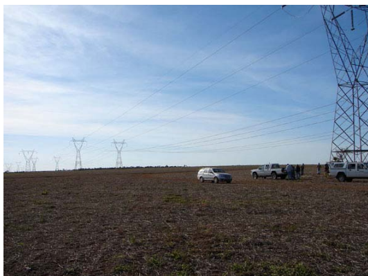
FIGURA 7 – Torre e vão de teste.
