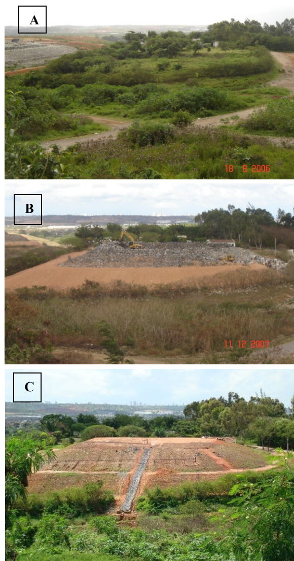
Figura 1. Ilustração da implantação da célula experimental no Aterro da Muribeca/PE.
