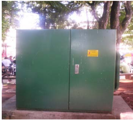
Figura 3- Transformador Pedestal
