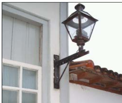
Figura 4- Lampião colonial instalado com voluta reta
