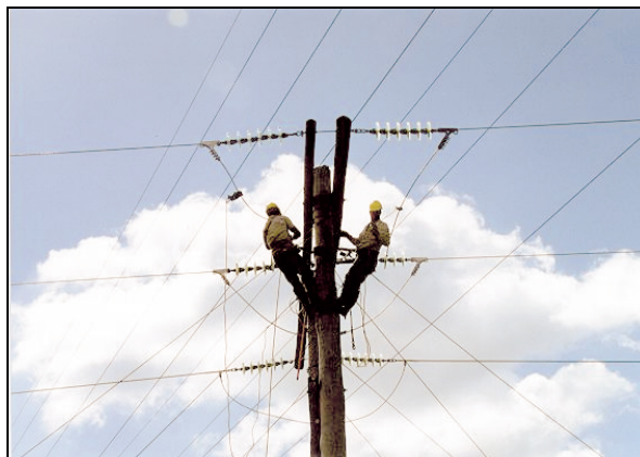
FIGURA 1 – Instalação dos novos cabos na LT Experimental
