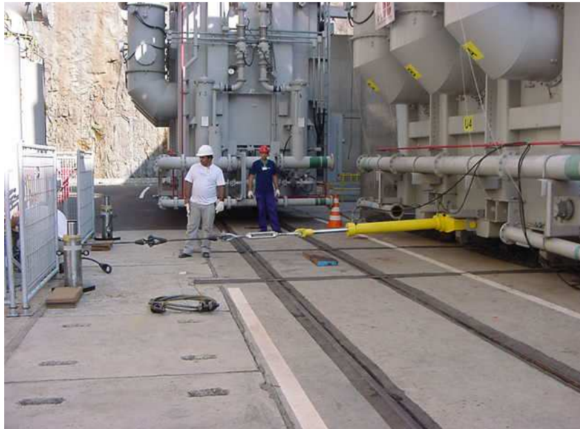
FIGURA 4 - Substituição do transformador da unidade 04.
