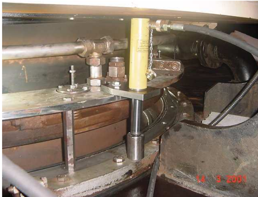
FIGURA 1 - Levantamento da tampa superior da vedação deslizante.
