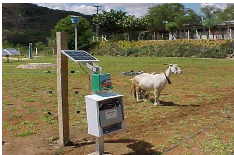
Figura 3. Aplicações produtivas com energia solar fotovoltaica: cerca elétrica e sistema de telefonia rural e iluminação pública.
