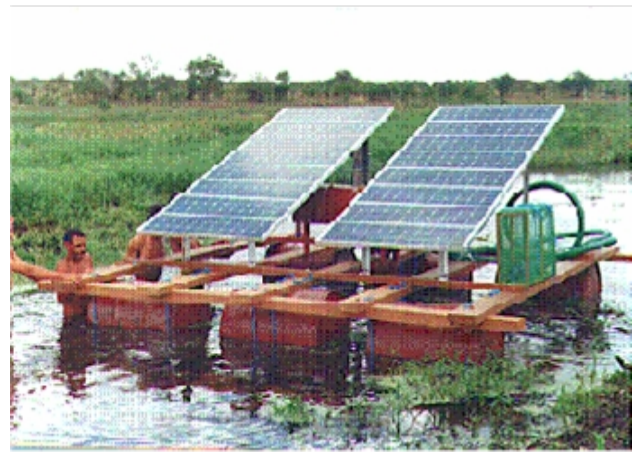
Fig.ura 4. Aplicações comunitárias da energia solar fotovoltaica: escola e bombeamento de água com sistema flutuante..
