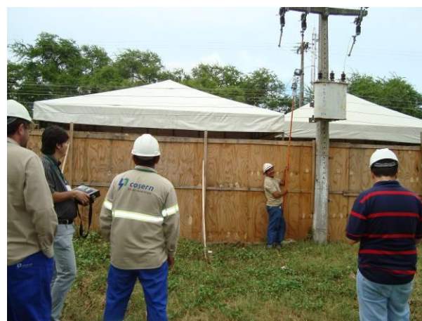
Figura 15. Teste feito nas instalações elétricas da COSERN.
