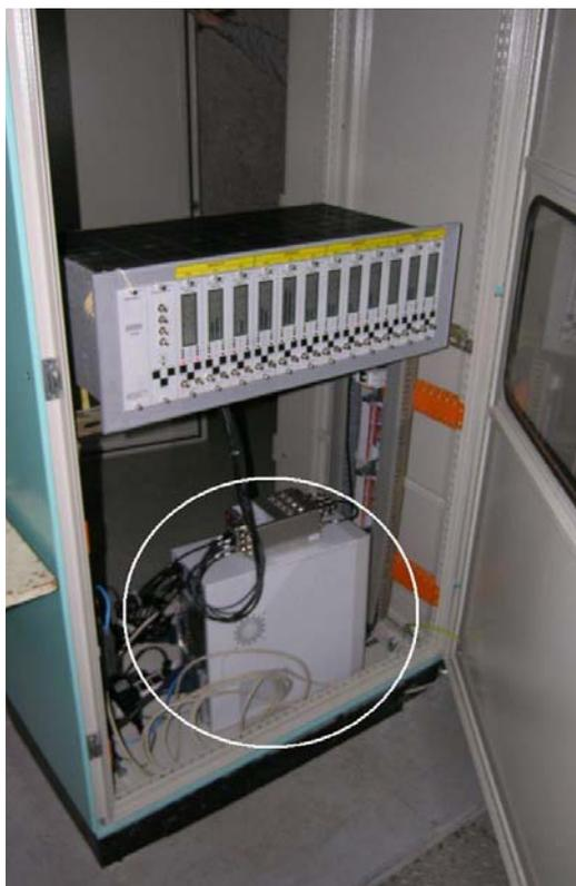
FIGURA 2 - Sistema de monitoramento instalado junto ao sistema de medição de oscilação no eixo na UHE de GBM.
