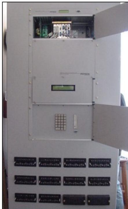
FIGURA 1 – Exemplo de equipamento RDP montado em uma Subestação.
