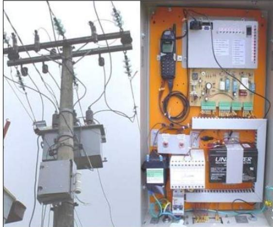
FIGURA 5 – Religador de energia utilizando celular TDMA.
