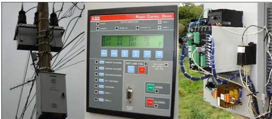
FIGURA 6 – Religador de Energia utilizando modem GPRS.
