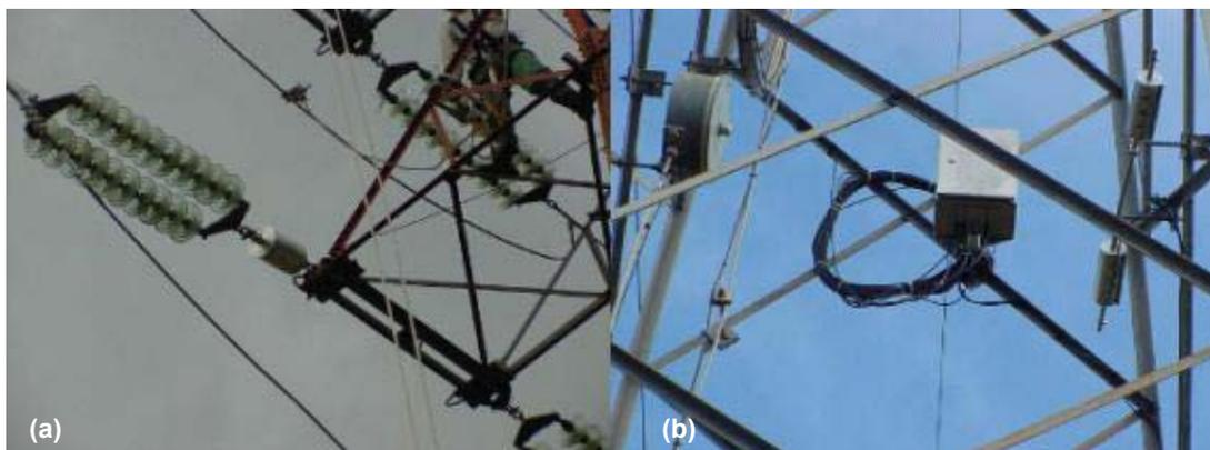
FIGURA 9 - (a) Aplicação do sensor de força óptico na linha. (b) Sensores de vibração e temperatura do SOMLT.
