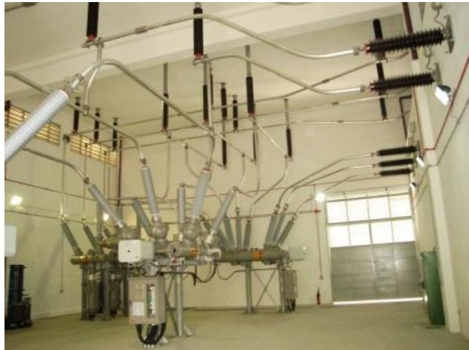
FIGURA 5 – Barramentos e módulos SF6
