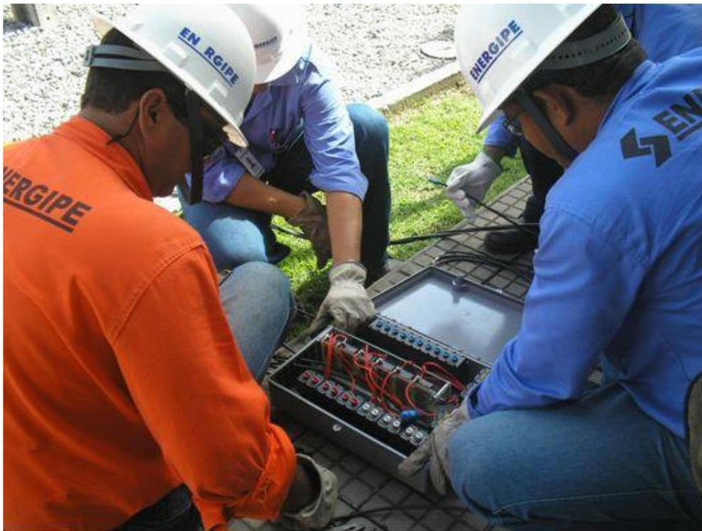
**Figura 5 – Eletricistas da ENERGIPE ligando as cargas de teste na caixa automatizada.**
