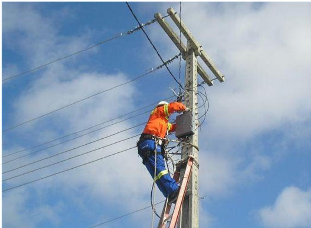
**Figura 6 – Eletricista posicionando a caixa/módulo atuador no poste.**
