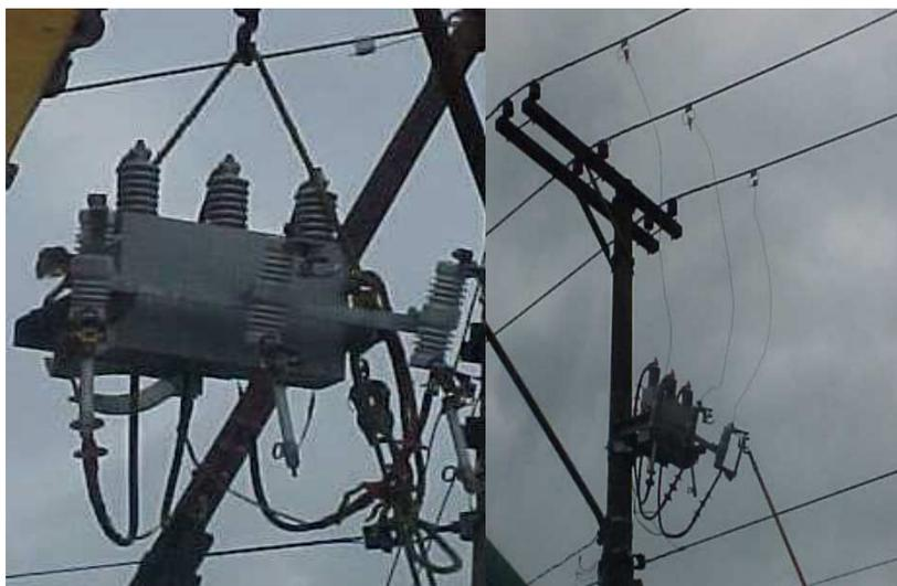
Figura 2. Protótipo do Banco Relocável iniciando o içamento
