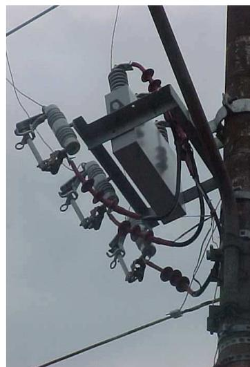
Figura 4. Protótipo do Banco Relocável em operação
