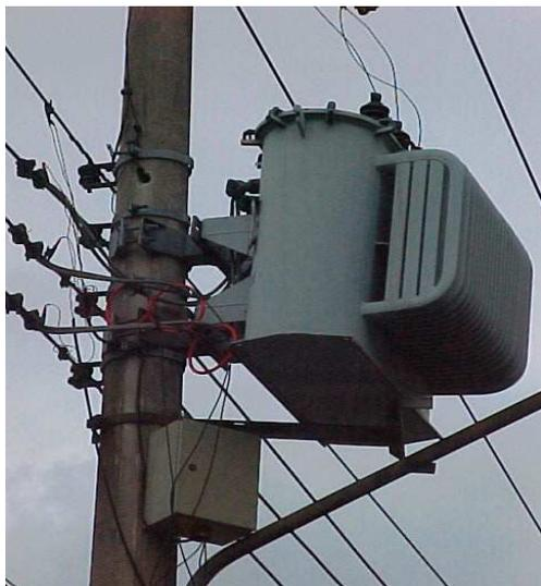
Figura 5 – Equipamento de medição junto ao transformador
