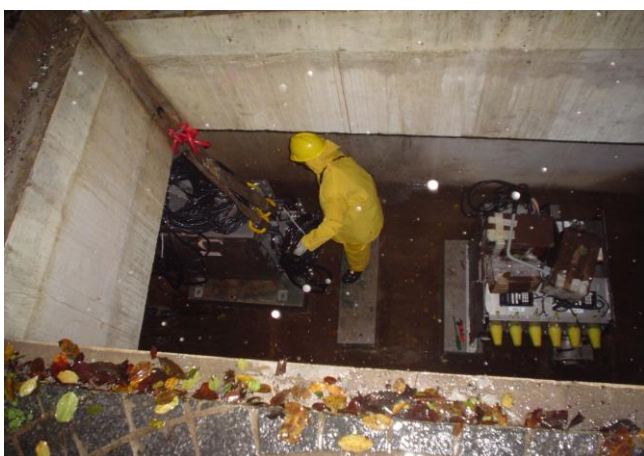
Figura 15. Acomodação das chaves e painéis sobre as bases de concreto
