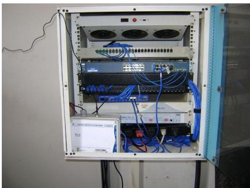
**Figura 9.** Concentrador instalado na subestação da concessionária.
