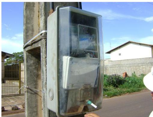
**Figura 8.** Terminal PLC instalado em medidor eletrônico.
