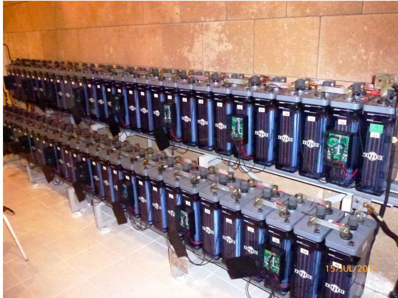
Figura 7: Protótipo instalado no banco de baterias para teste de campo
