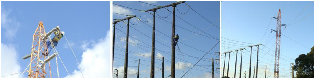
Figura 11 – Lançamento dos Condutores
