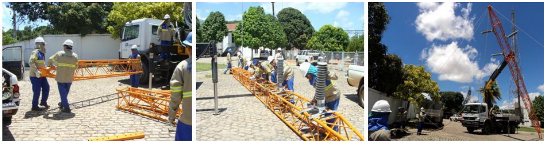
Figura 10 – Montagem da Estrutura de Emergência
