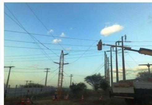
Figura 16 – Conexão com Linha Viva
