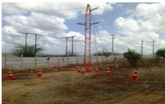
Figura 14 – Estrutura de Emergência
