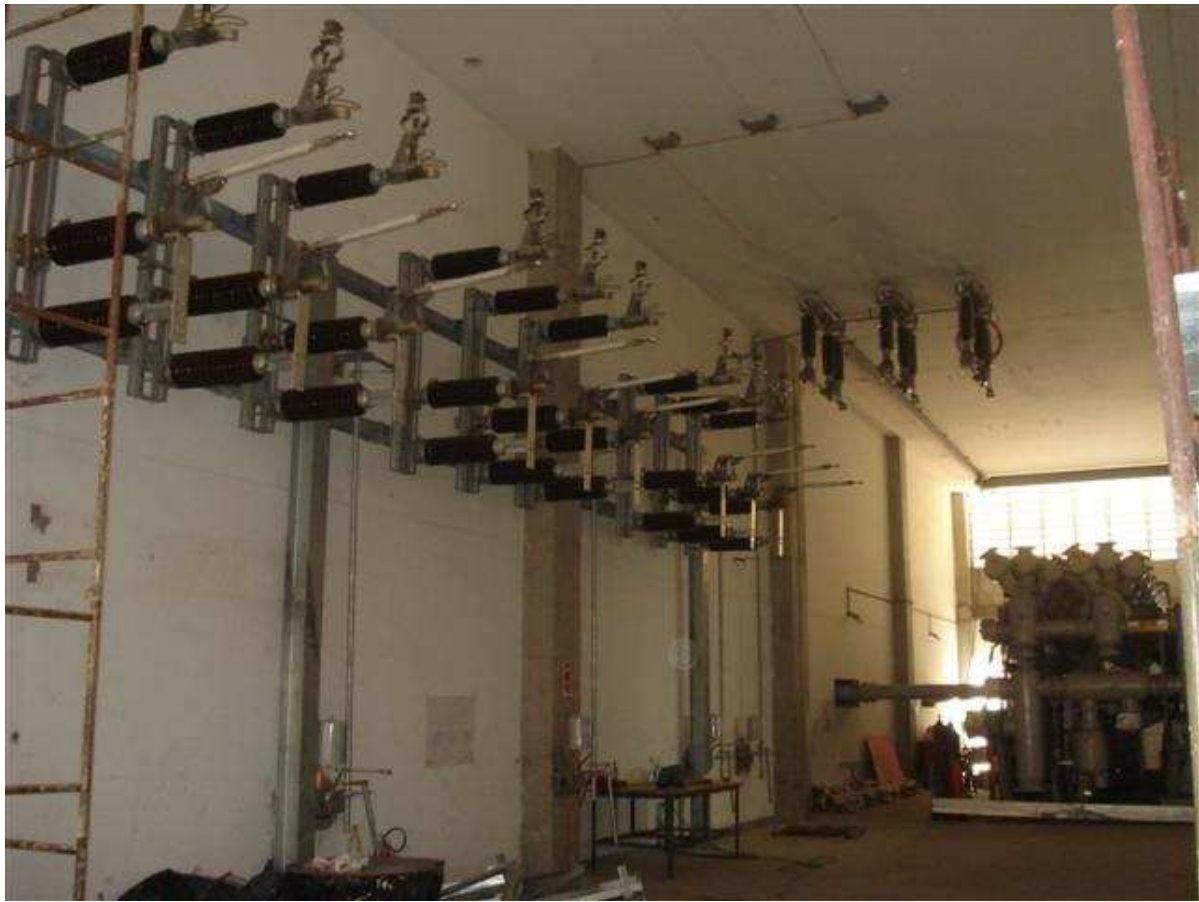
Figura 4 – construção do novo barramento
