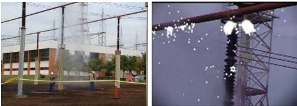
FIGURA 11 – Foto da lavagem de isoladores de pedestal (esquerda) e imagem visível e UV combinadas.
