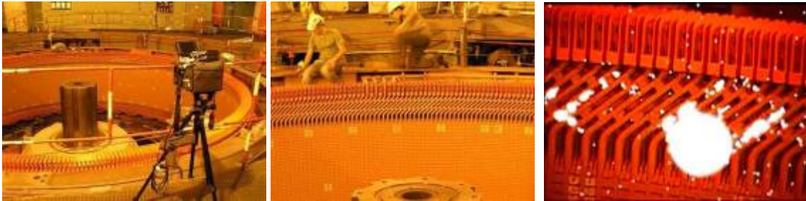
FIGURA 14 – Monitoramento de efeito corona em estator de gerador
