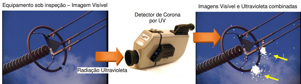
FIGURA 6 – Combinação da imagem visível e da radiação UV pela Detecção de Corona por UV.
